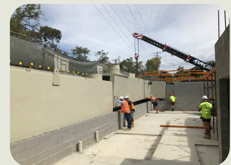
Soudage des modules sur place
