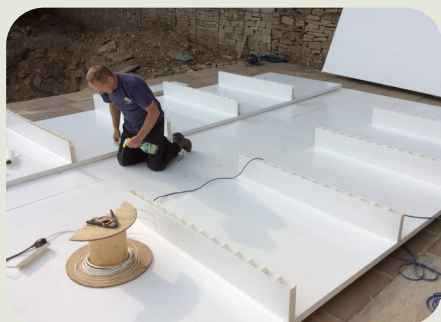
Soudure de la piscine sur place
