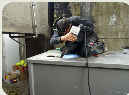
Construire un réservoir dans un espace réduit
