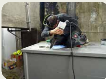
Konstruktion eines Tanks auf engem Raum
