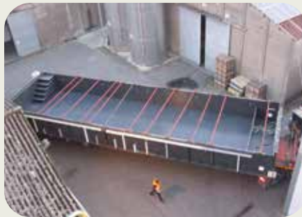
Transport eines großen Schwimmbeckens
