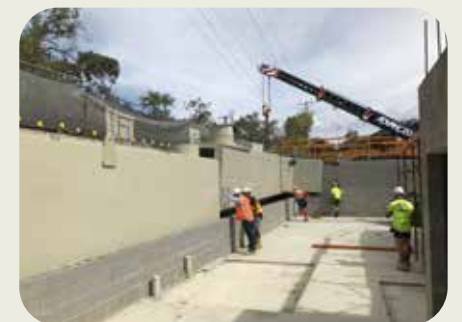
Verschweißen von Modulen vor Ort
