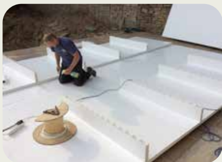
Verschweißen eines Schwimmbeckens am Standort
